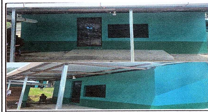
Foto 11: Reparación de cocina, ampliación RENGLON 8
