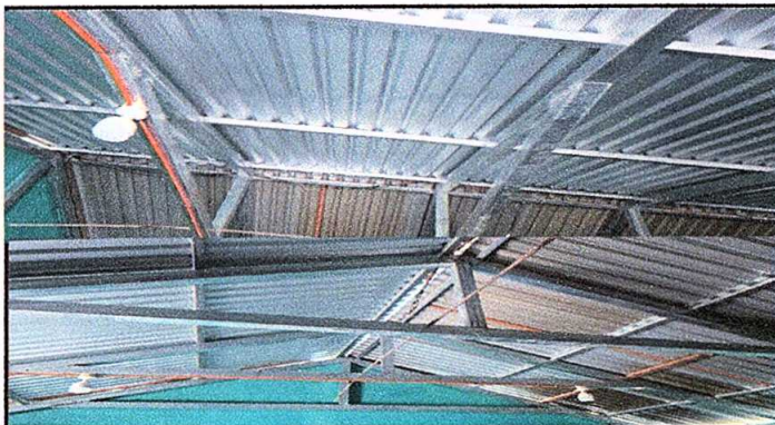
Foto 3: Sustitucion de estructura de soporte de madera por metal RENGLÓN 2
