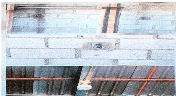
Foto 9: Reparación del sistema eléctrico cocina RENGÓN 7
