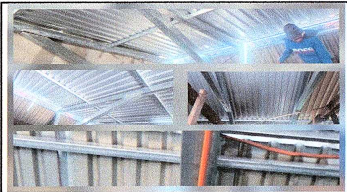
Foto 3: Sustitución de estructura de soporte de madera por metal RENGLÓN 2
