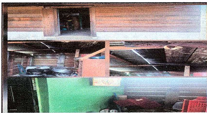
Foto 11: Reparación de cocina, ampliación RENGÓN 8
