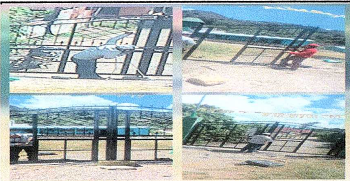
Foto 5: Sustitución del portón RENGLON 3
