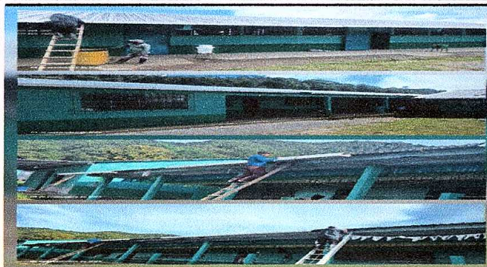
Foto7: Instalación de canales PVC RENGÓN 5
