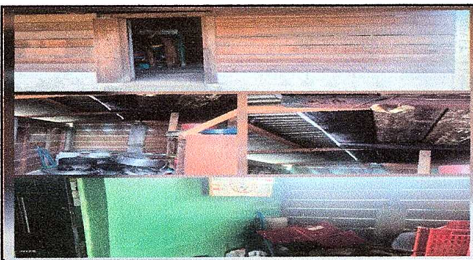
Foto 11: Reparación de cocina, ampliación REGLON 8
