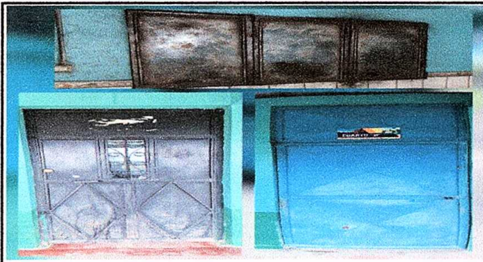
FOTO 1: Mantenimiento de puertas y ventana
