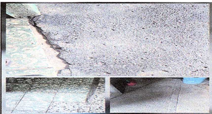
Foto 6: Piso Sustitución de piso de granito RENGLO 4
