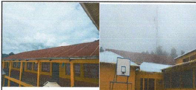
Foto1: Sustitución de lámina en mal estado.
