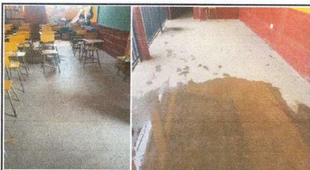
Foto 3: Sustitución de piso de granito.
