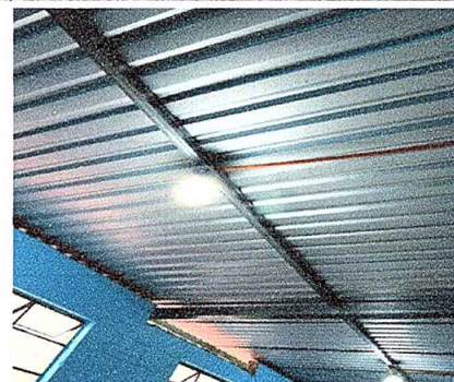
Foto 2: Sustrución de Sistema Eléctrico.
