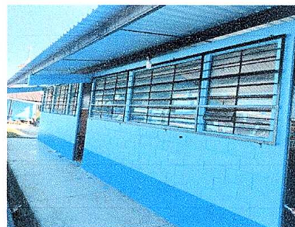
Foto 6: Mejoramiento de balcones de metal
