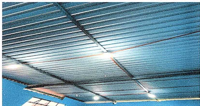
Foto 1: Sustrución de lámina por lámina troquelada
