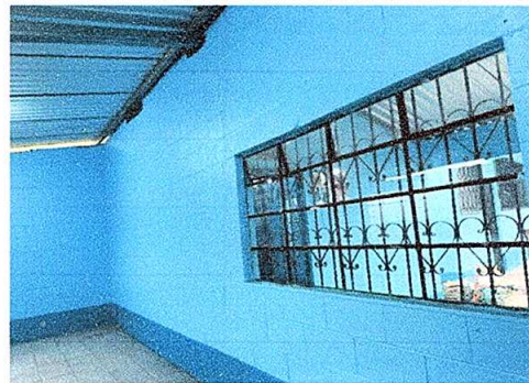
Foto 4: Aplicación de pintura a paredes interiores y exteriores
