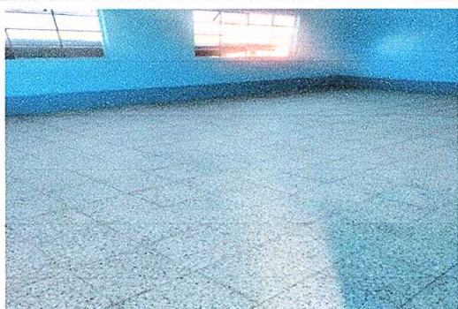
Foto 5: Reparación de piso de torta de cemento por piso granito.
