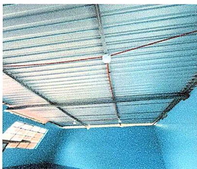
Foto 1: Sustitución de estructura de soporte de madera por metal
