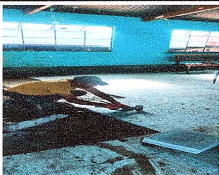
Foto 5: Reparación de piso de torta de cemento por piso granito.
