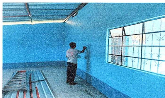
Foto 4: Aplicación de pintura a paredes interiores y exteriores
