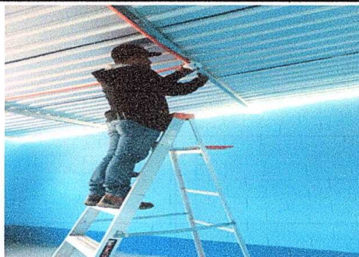
Foto 2: Sustrucción de Sistema Eléctrico.
