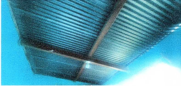
Foto 1: Sustitución de estructura de soporte de madera por metal
