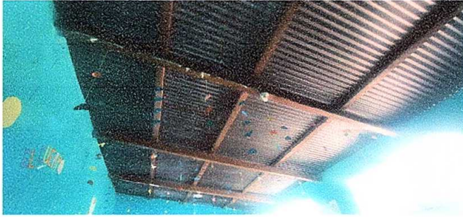
Foto 1: Sustrución de lámina por lámina troquelada
