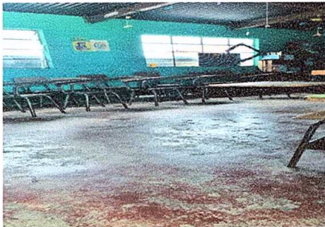
Foto 5: Reparación de piso de torta de cemento por piso granito.
