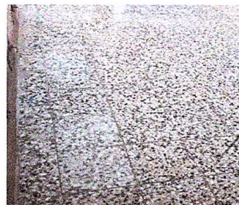
Foto 6: Sustitución de piso de granito
