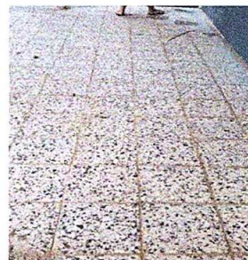
Foto 4: Sustitución de piso de granito
