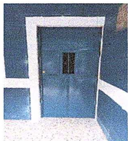
Foto 5: Sustitución de puerta (2.00m * 1.00m)
