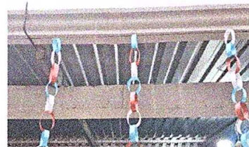
Foto 2: Sustitución de canal de pvc
