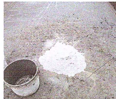
Foto 4: Sustrucción de piso de granito
