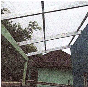
Foto 3: Sustrucción de estructura de soporte de madera, por metal
