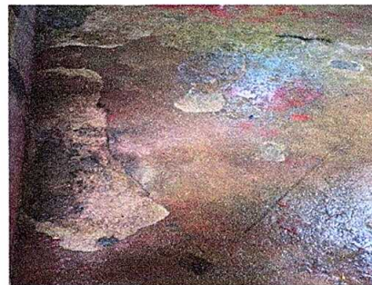
Foto 6: Sustrución de piso de granito
