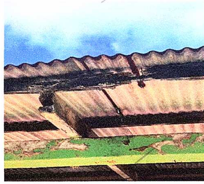
Foto 2: Sustrución de canal de pvc
