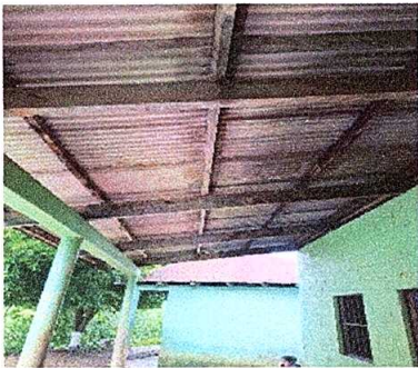
Foto 3: Sustrución de estructura de soporte de madera, por metal
