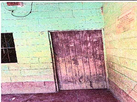
Foto 5: Sustrución de puerta (2.00m * 1.00m)
