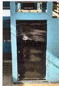
Foto 2: Sustitución de Puerta en sanitario de metal 1 metros X 2.14 metros
