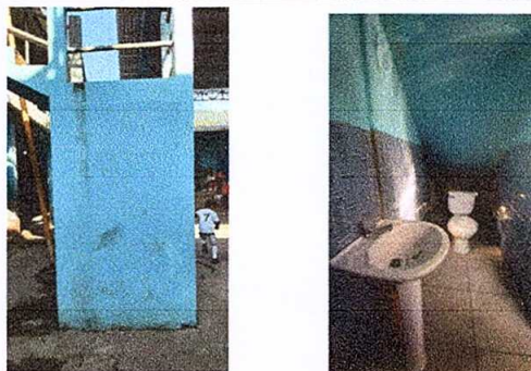
Foto 6: Sustitución inodoro, Mejoramiento de pared de servicio sanitario, Sustitución lavamanos
