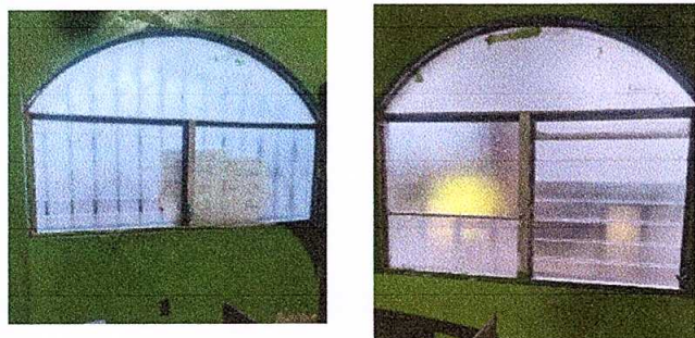
Foto 9: Sustitución de ventanas de aluminio por aluminio mas vidrio 1.8 metros x 1.10 metros
