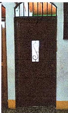
Foto 3: Sustitución de puerta en dirección de madera a metal
