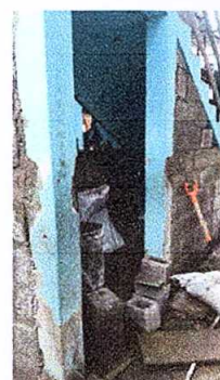
Foto 4: Sustitución de piso de granito
