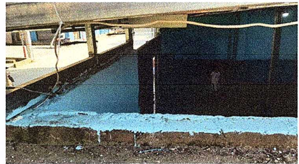
Foto 8: Mejoramientos de fachada de portón
