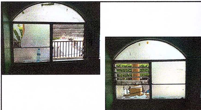
Foto 9: Sustitución de ventanas de aluminio por aluminio mas vidrio 1.8 metros x 1.10 metros
