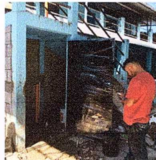
Foto 2: Sustitución de Puerta en sanitario de metal 1 metros X 2.14 metros
