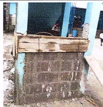
Foto 6: Sustitución inodoro, Mejoramiento de pared de servicio sanitario, Sustitución lavamanos
