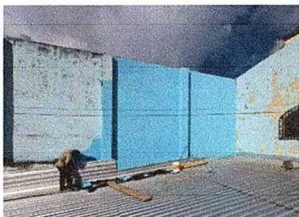
Foto 5: Pintura en muros interiores y exteriores
