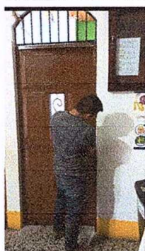
Foto 3: Sustitución de puerta en dirección de madera a metal
