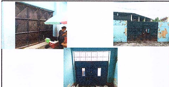
Foto 7: Mantenimiento a portones de metal de 2.62metros x 3.80 metros, 2.58 metros x 3 metros y 3 metros x 2.20 metros
