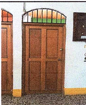
Foto 3: Sustrucción de puerta en dirección de madera a metal
