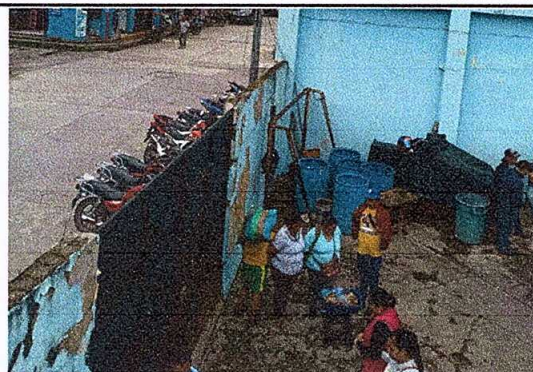
Foto 8: Mejoramientos de fachada de portón
