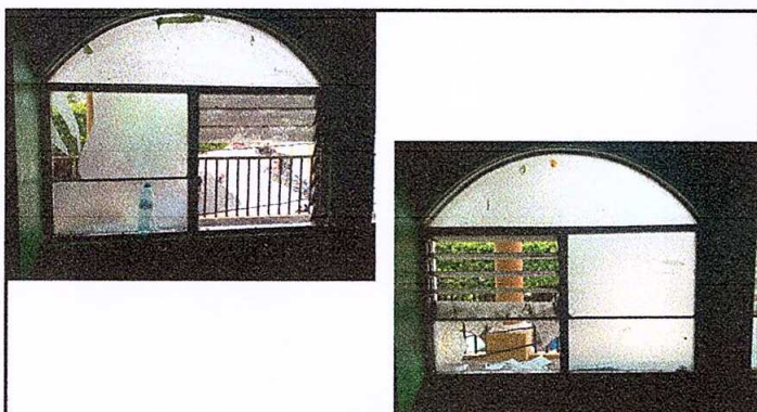
Foto 9: Sustitución de ventanas de alumbrío por aluminio mas vidrio 1.8 metros x 1.10 metros
