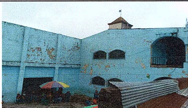
Foto 5: Pintura en muros interiores y exteriores
