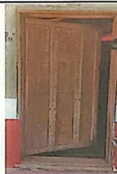
Foto4: Sustrucción de puertas de madera por metal
