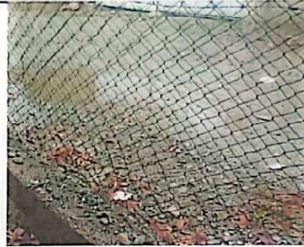
Foto8: Reparación de tubo hg y malla galvanizada
