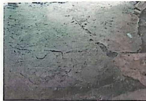
foto10: Reparación de plancha de concreto de patio
