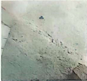
foto7: Sustrucción de piso de torta de concreto
