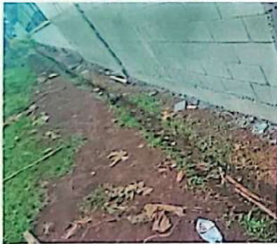
foto9: Reparación de banqueta de concreto
