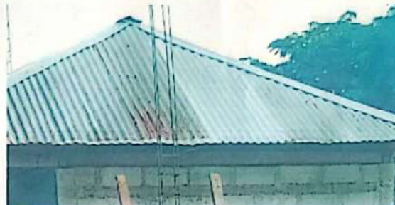
Foto2: Sustrucción de capote de lámina, para lámina troquelada.
