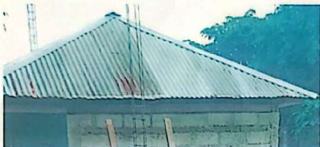
Foto1: Sustrucción de lámina, por lámina troquelada calibre 26
