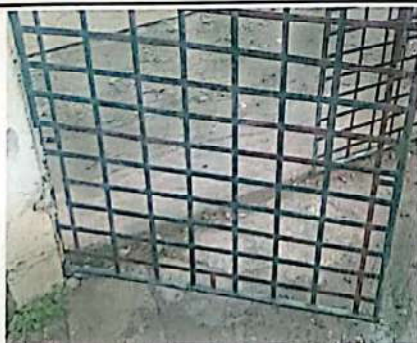
Foto5: Sustrucción de portón de metal
