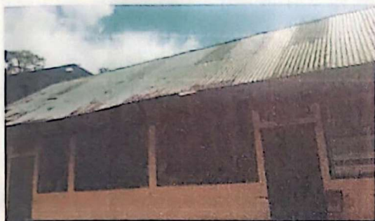
Foto1: Sustrucción de lámina por lámina Aluzinc troquelada.
