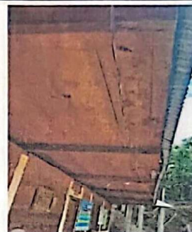
Foto 2: Sustrucción de estructura de madera portante de lámina por estructura metálica portante de lámina.
