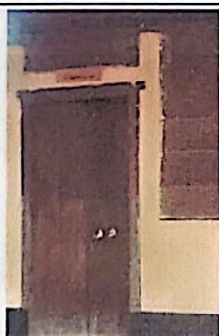
Foto 3: sustitución de puerta de madera por puerta de metal.
