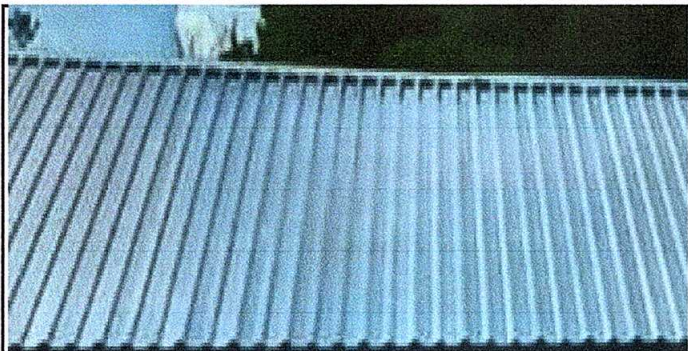
Foto1: Sustitución de lámina
