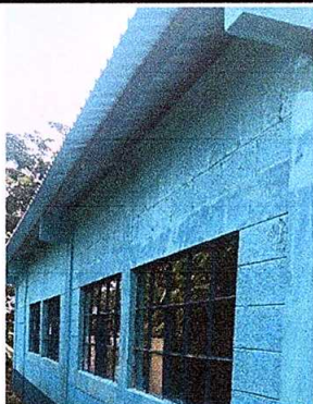
Foto1: Pintura en muros exteriores e interiores
