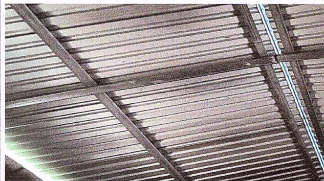
Foto 2: Sustitución de estructuras de soporte
