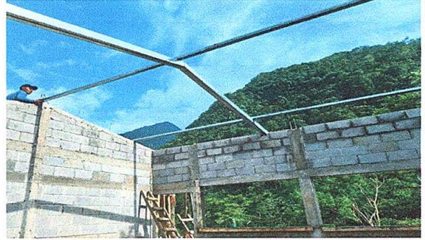
Foto 2: Sustitución de estructuras de soporte
