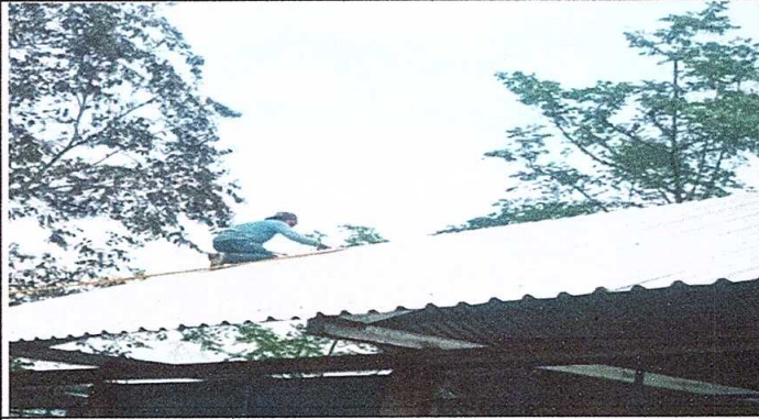
Foto1: Sustitución de lámina
