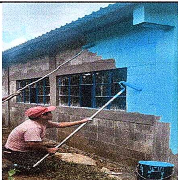
Foto1: Pintura en muros exteriores e interiores
