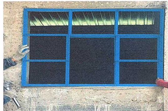
Foto 4: Sustitución de ventanas
