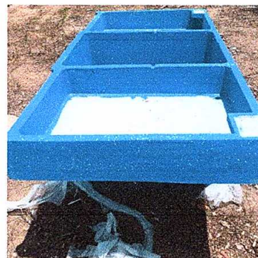
Foto 2: Mejoramiento de Pila
