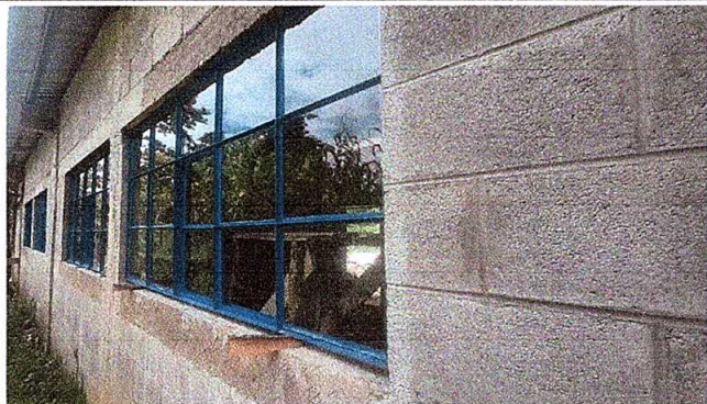
Foto1: Pintura en muros exteriores e interiores
