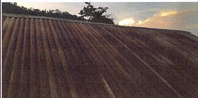
Foto1: Sustitución de lámina
