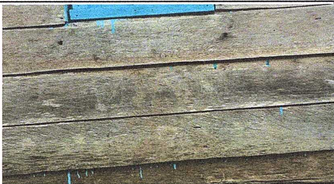
Foto 5: Mejoramiento de pared
