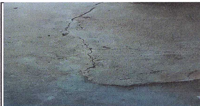
Foto 6: Sustitución de piso
