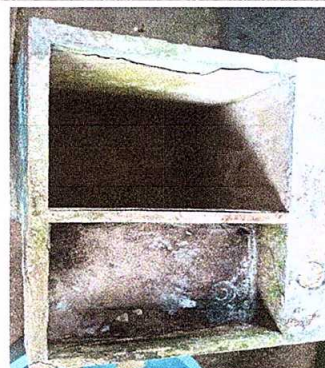
Foto 2: Mejoramiento de Pila
