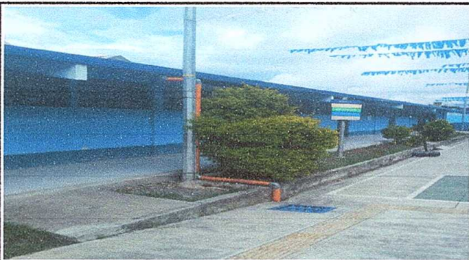
Foto 3: Mejoramiento de canal para bajadas de agua pluvial
