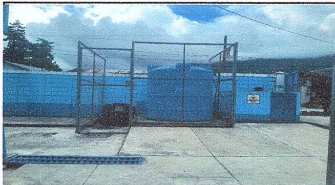
Foto 4: Mejoramiento de malla y tubo para el resguardo del depósito de agua
