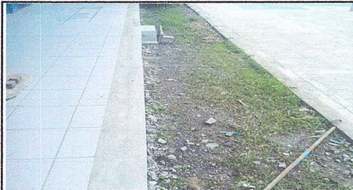
Foto 8: Mejoramiento tubería PVC de agua potable
