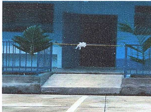
Foto 2: Mejoramiento de Puerta de metal de 1 metro de ancho por 2 metros de alto color azul nacional con chapa marca yale en cocina
