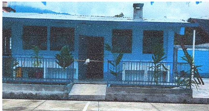
Foto7: Pintura en muros exteriores e interiores
