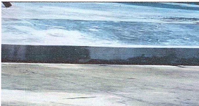
Foto 6: Mejoramiento de torta de concreto
