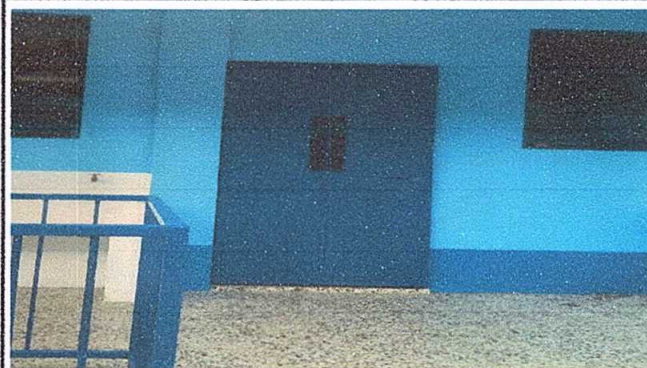
Foto 2: Mejoramiento de Puerta de metal de 1 metro de ancho por 2 metros de alto color azul nacional con chapa marca yale en cocina
