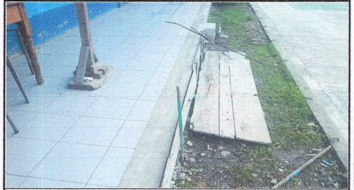
Foto 8: Mejoramiento tubería PVC de agua potable
