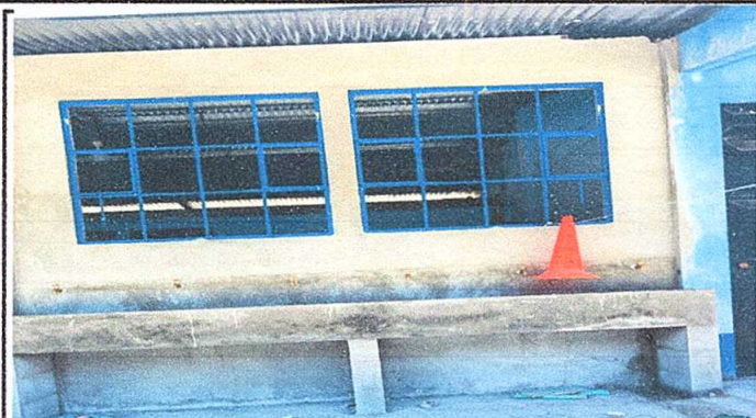
Foto1: Mejoramiento de ventanas de metal en cocina de 1.13 metros de ancho por 1.20 metros de alto.
