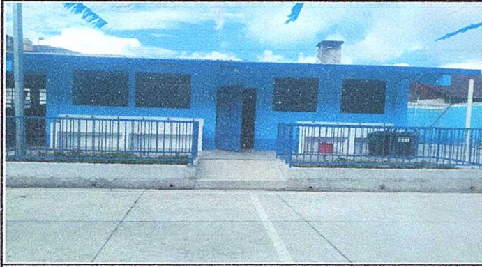
Foto7: Pintura en muros exteriores e interiores
