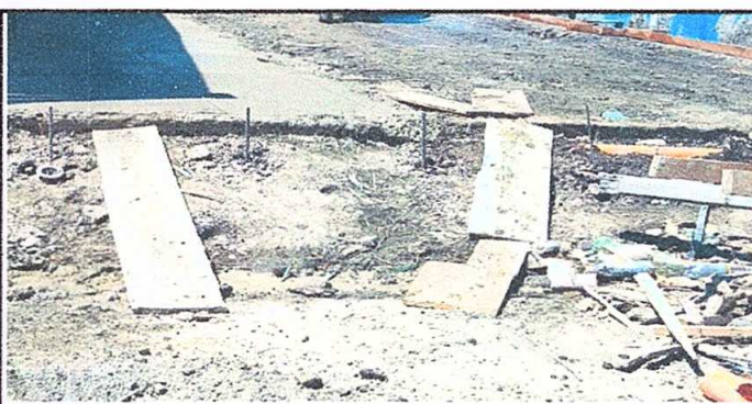
Foto 6: Mejoramiento de torta de concreto
