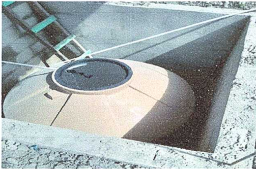
Foto 9: Reparación de cisterna de concreto (Repello e impermeabilización)
