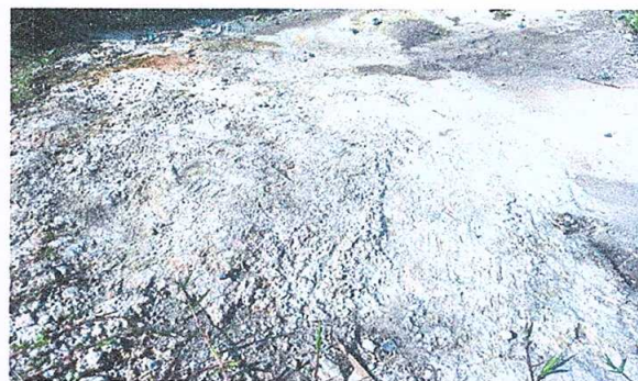
Foto 6: Mejoramiento de torta de concreto
