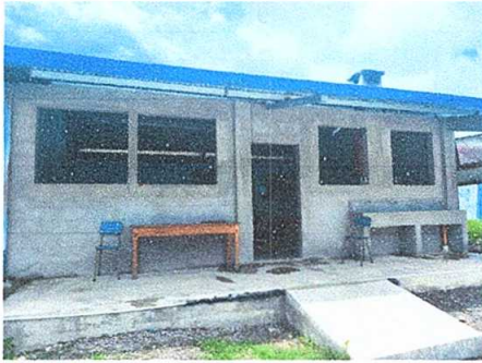
Foto 7: Pintura en muros exteriores e interiores
