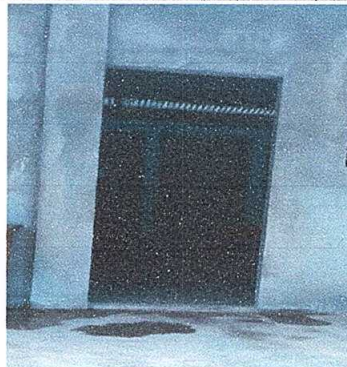
Foto 2: Mejoramiento de Puerta de metal de 1 metro de ancho por 2 metros de alto color azul nacional con chapa marca yale en cocina
