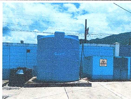
Foto 4: Mejoramiento de malla y tubo para el resguardo del depósito de agua
