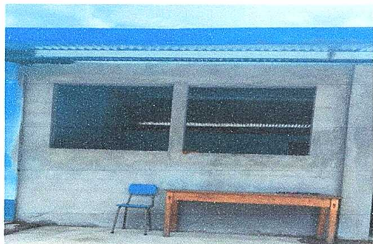
Foto1: Mejoramiento de ventanas de metal en cocina de 1.13 metros de ancho por 1.20 metros de alto.
