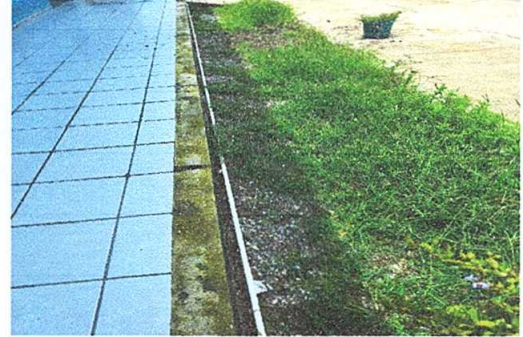
Foto 8: Mejoramiento tubería PVC de agua potable
