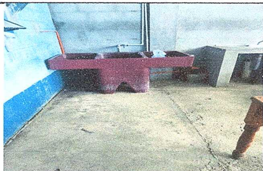
Foto 5: Sustitución de torta de cemento por piso de granito
