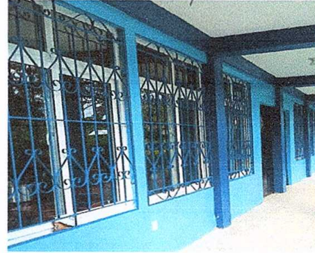
Foto 2: Sustitución de balcones de metal (1.50m*1m) (4 balcones)
