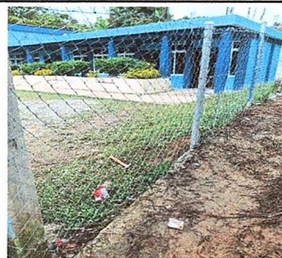
Foto 4: Reparación de tubo hg y malla galvanizada
