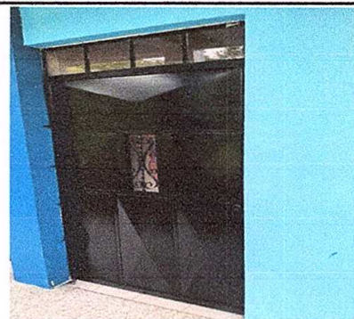
Foto 6: Sustitución de puerta (2.m de alto * 1m de ancho)
