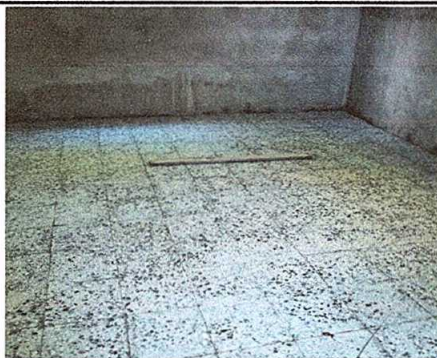
Foto 5: Sustitución de piso de granito
