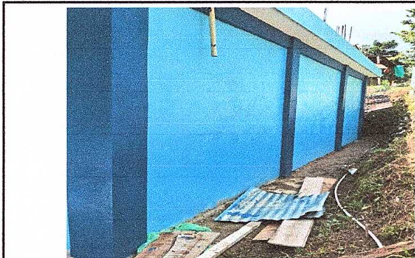
Foto 7: Pintura en muros exteriores e interiores
