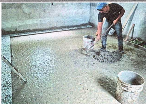
Foto 5: Sustitución de piso de granito
