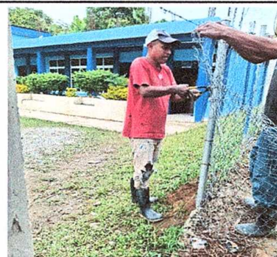
Foto 4: Reparación de tubo hg y malla galvanizada
