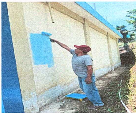
Foto 7: Pintura en muros exteriores e interiores
