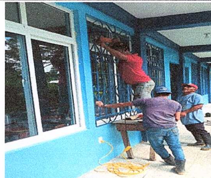
Foto 2: Sustitución de balcones de metal (1.50m*1m) (4 balcones)
