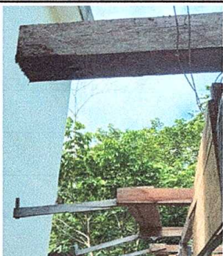
Foto 3: Sustitución de estructura de soporte de madera, por metal
