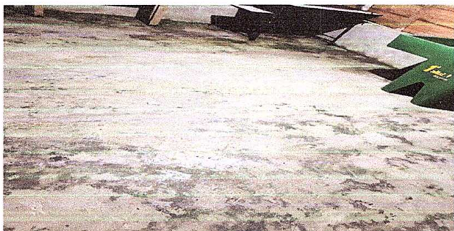
Foto 5: Sustitución de piso de granito
