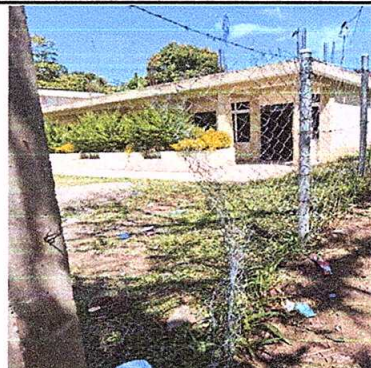
Foto 4: Reparación de tubo hg y malla galvanizada
