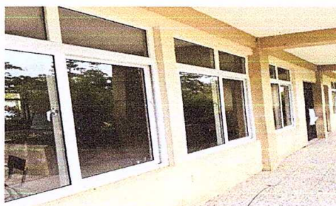
Foto 2: Sustitución de balcones de metal (1.50m*1m) (4 balcones)
