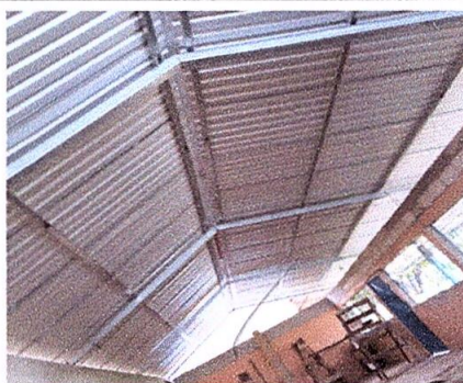
Foto 2: Sustrucción de estructura de soporte de madera, por metal
