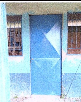
Foto 5: Sustrucción de puerta (2.25m * 1.00m)
