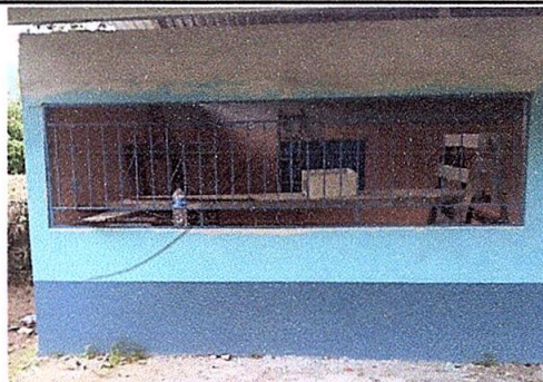
Foto 4: Sustrucción de balcones de metal (2.35m*1.15m)(2 balcones)
