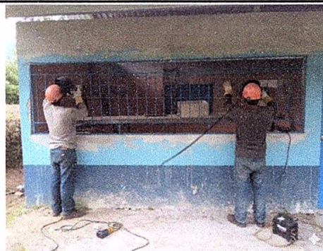
Foto 4: Sustitución de balcones de metal (2.35m*1.15m)(2 balcones)
