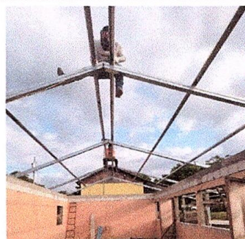
Foto 2: Sustitución de estructura de soporte de madera, por metal
