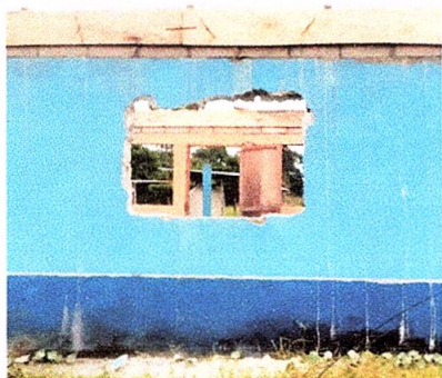
Foto 3: Sustitución de estructura de metal de ventana (1.5m*1m)
