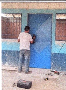
Foto 5: Sustitución de puerta (2.25m * 1.00m)
