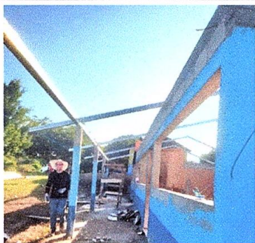
Foto1: Sustitución de lámina, por lámina troquelada aluzinc calibre 26
