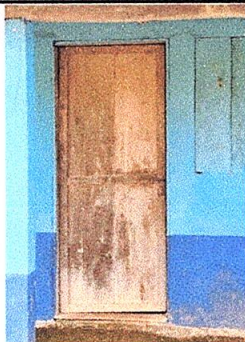
Foto 5: Sustrución de puerta (2.25m * 1.00m)
