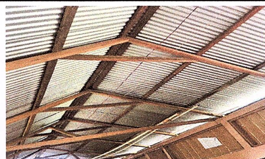
Foto 6: Sustrución de lámina, por lámina troquelada aluzinc calibre 26
