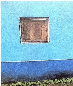
Foto 3: Sustrución de estructura de metal de ventana (1.5m*1m)
