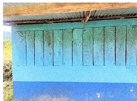
Foto 4: Sustrución de balcones de metal (2.35m*1.15m)(2 balcones)
