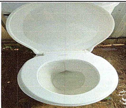
Foto 5: En la fotografía se puede evidenciar que se ha cambiado las tapaderas de los sanitarios que estaban en mal estado.
