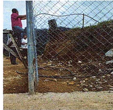
Foto 2: En esta fotografía se puede observar el cambio de tubo hg y malla galvanizada del centro educativo.
