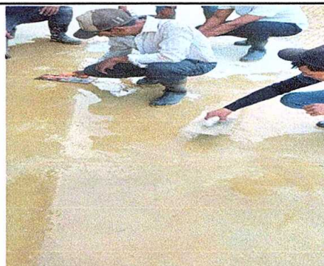
Foto 4: Se evidencia la colocación de losa de patio en proceso de ejecución.
