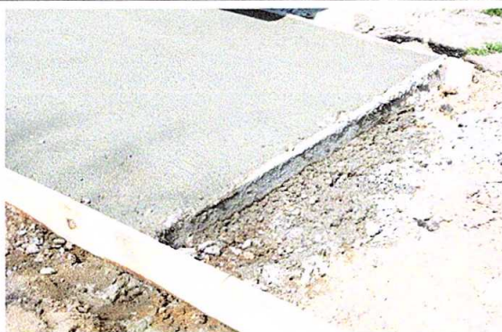
Foto 3: En la fotografía se evidencia proceso de la colocación de banquetas de concreto del establecimiento.
