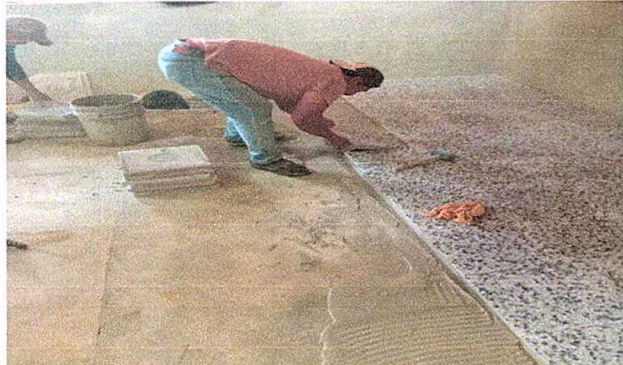
Foto1: En esta fotografía se puede evidenciar la colocación de pisos de granito en proceso en aulas del centro educativo.
