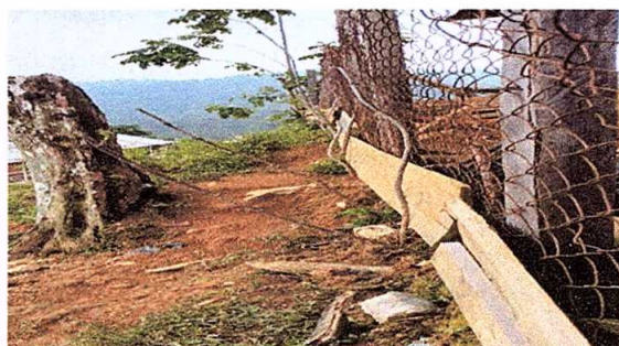
Foto 2: malla remendada con tabla
