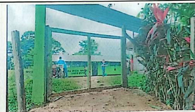
Foto 4: Sustitución de portón de metal.
