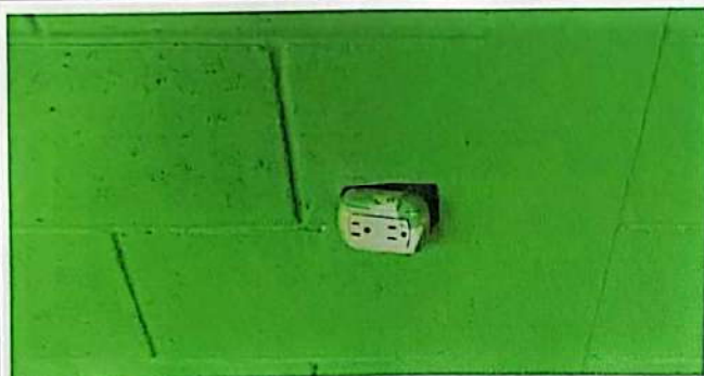
Foto 13: Sustrucción de tomacorrientes
