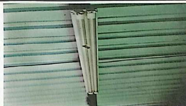
Foto 12: Sustitución de lamparas tipo LED
