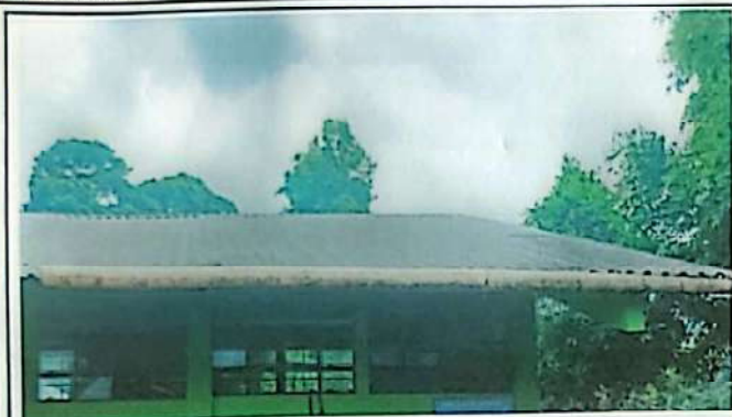
Foto1: Sustitución de lamina por lámina troquelada.
