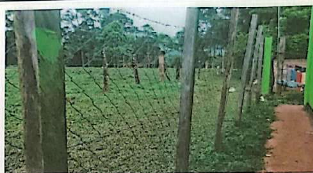
Foto 10: Sustitución de postes de madera por tubo hg, malla galvanizada
