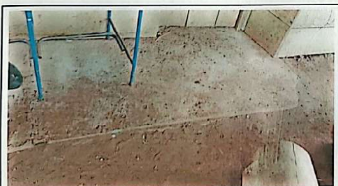
Foto 5: Sustitución de piso de torta de concreto
