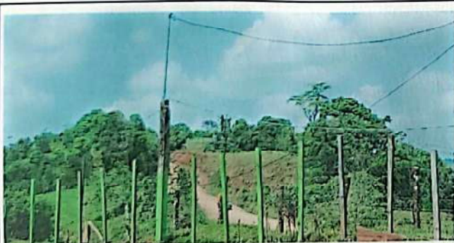
Foto 11: Sustitución de cableado eléctrico.
