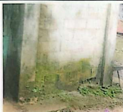
Foto 9: Reparación de pared en servicios sanitarios
