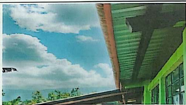
Foto 6: Sustitución de canal de pvc
