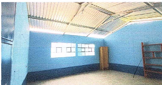
foto. 3 ESTRUCTURA D METAL
