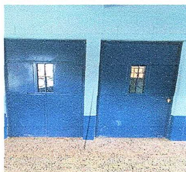
foto. 4 COLOCACIÓN DE PUERTAS
