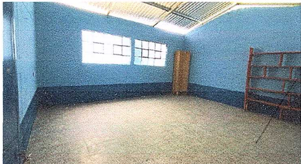
Foto 1 INSTALACIÓN DE PISO DE GRANITO
