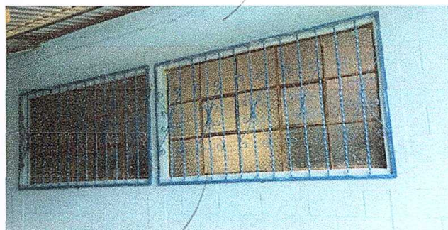
foto. 2 TERMAION DE COLOCAR LOS BALCONES
