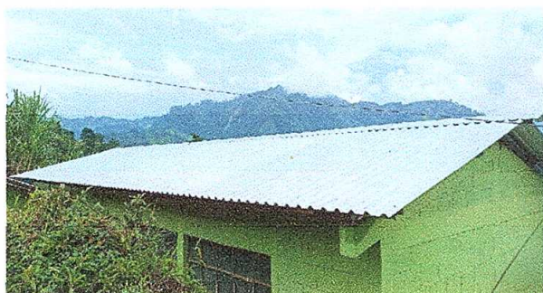
Foto 1 TERMINACIÓN DE INSTALACION DE LAMINA
