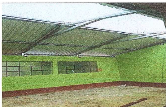
foto. 3 INSTALACIÓN DE ESTRUCTURA DE METAL POR MADERA
