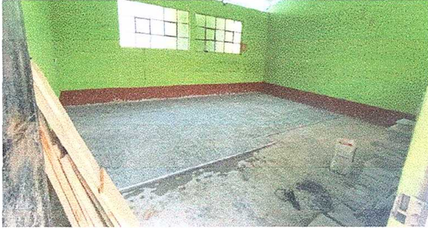
Foto 1 INSTALACIÓN DE PISO DE GRANITO
