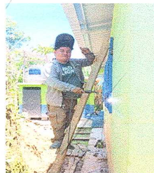
foto. 2 INSTALACIÓN DE VALCONES
