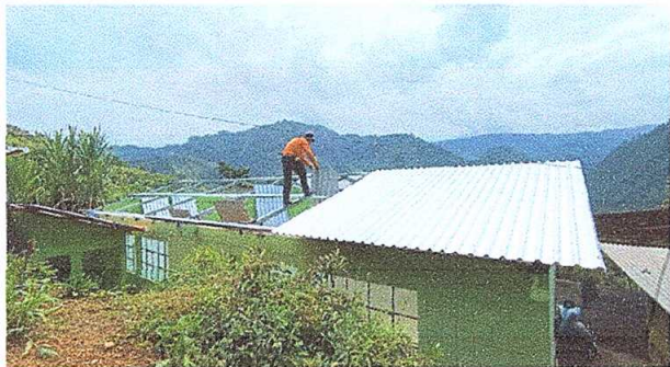
Foto 1 SUSTITUCION DE LAMINA
