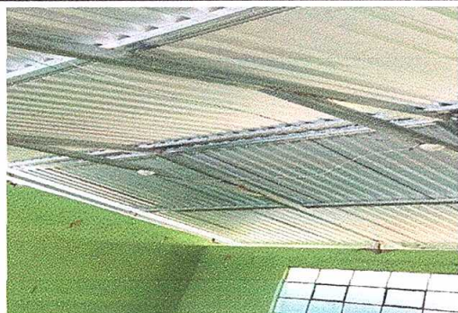
foto. 5 INSTALACIÓN DE SISTEMA ELECTRICO
