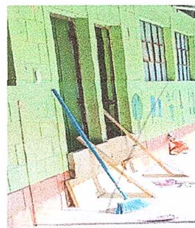
foto. 4 INSTALACIÓN DE PUERTAS
