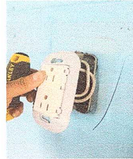
foto. 2 INSTALACIÓN DE TOMACORRIENTES DOBLES
