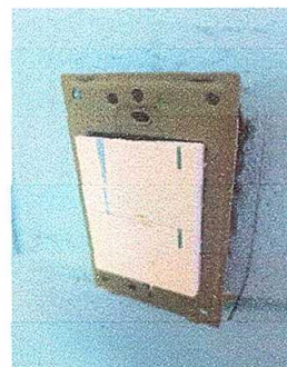
foto. 6 INSTALACION DE INTERRUPTORES DOBLES
