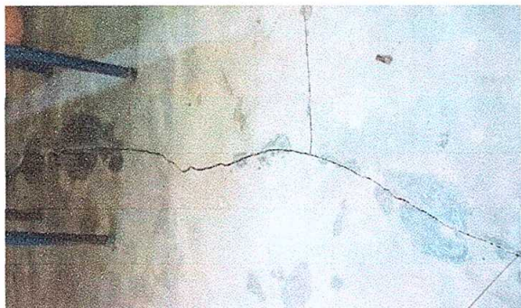
Foto1: sustitución de piso en mal estado
