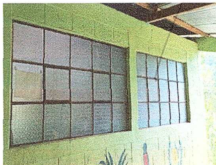
Foto 6: colocación de balcones
