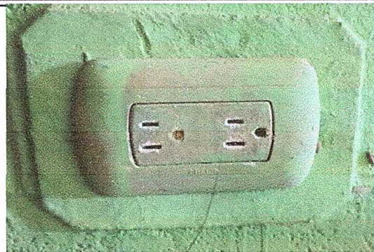
foto. 4: sustitución de tomacorrientes dobles
