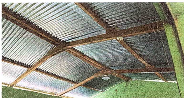
Foto 3: sustitución de estructura de madera por metal
