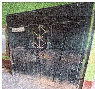
sustitución de puertas en mal estado.
