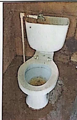
Foto 4: Sustrucción de inodoros
