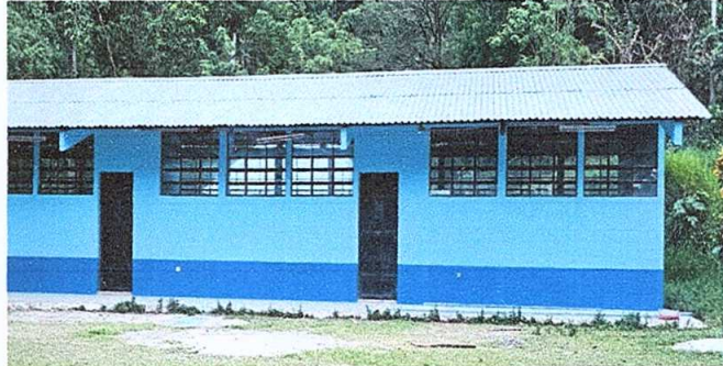
Foto 6: Pintura de muros interiores y exteriores
