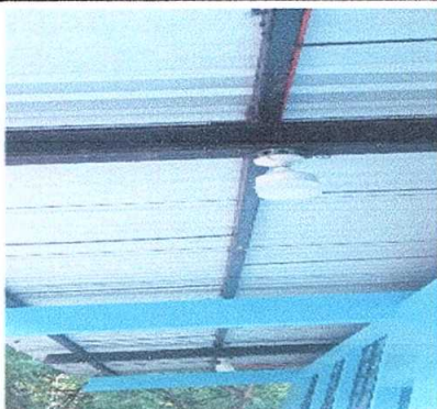
Foto7: Sustrucción de cableado elctrico
