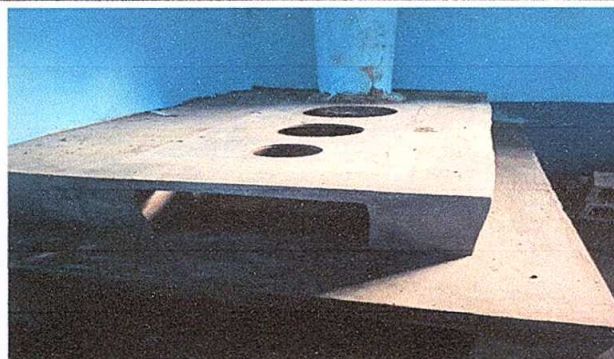
Foto 8: Sustrucción de plancha de metal
