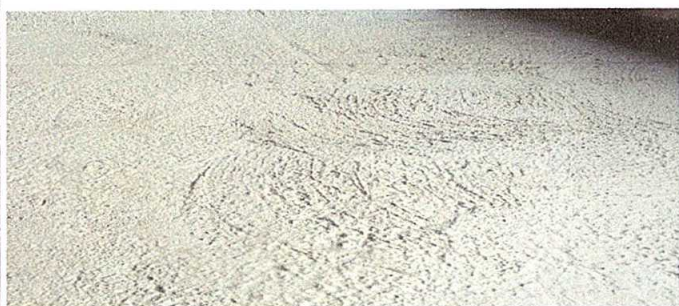
Foto 5: Sustitución de piso de concreto
