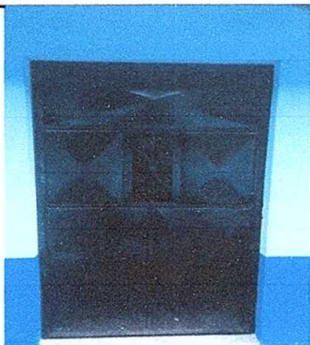
Foto 3: Sustitución de puerta de aula de 1.90 por 0.90 mts.
