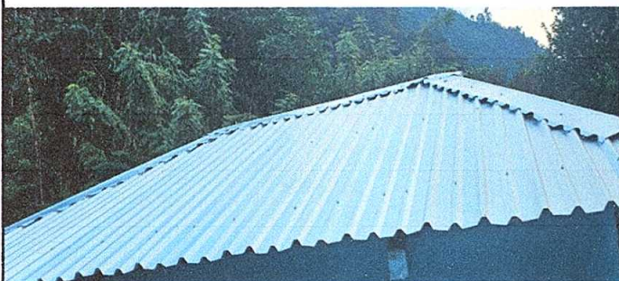
Foto1: Sustitución de lámina de cocina
