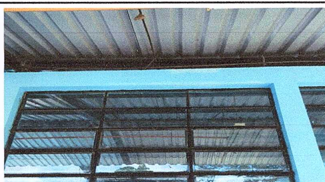
Foto 4: Sustitución de estructura de metal de ventana
