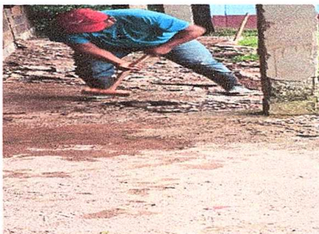
Foto 5: Sustitución de piso de torta de concreto
