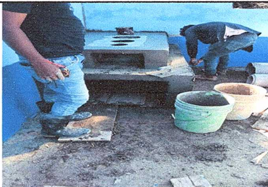
Foto 8: Sustitución de plancha de metal
