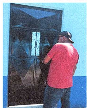
Foto 3: Sustitución de puerta de aula de 1.90 por 0.90 mts.
