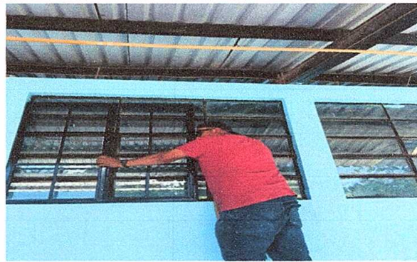
Foto 4: Sustitución de estructura de metal de ventana
