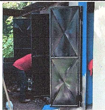
Foto 2: Sustitución de puertas en servicio sanitario
