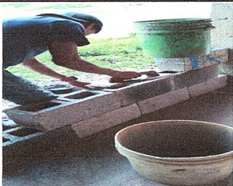
Foto1: Mejoramiento pared de Cocina
