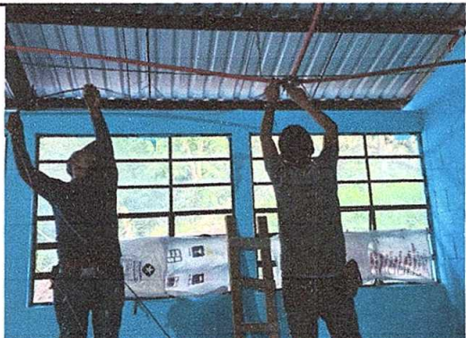
Foto7: Sustitución de cableado eléctrico
