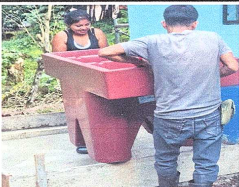
Foto 9: Sustitución de pila plástica de dos lavaderos
