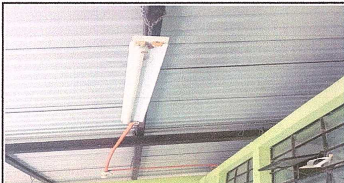
Foto7: Sustitución de cableado eléctrico
