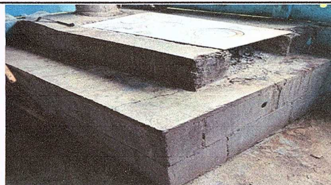
Foto 8: Sustitución de plancha de metal
