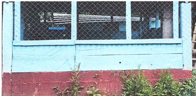
Foto1: Mejoramiento pared de Cocina
