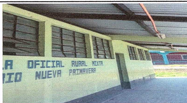
Foto 6: Pintura de muros interiores y exteriores
