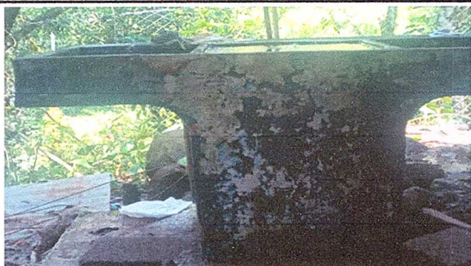
Foto 9: Sustitución de pila de plástica de dos lavaderos
