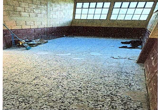
Foto 2: Renglón 2, sustitución de piso de granito (dirección)
