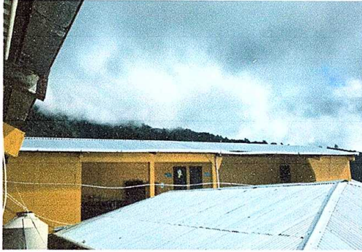
Foto1: Renglón 1, cubierta de lámina (segundo nivel)
