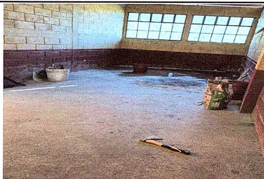
Foto 2: Renglón 2, sustitución de piso de granito (dirección)
