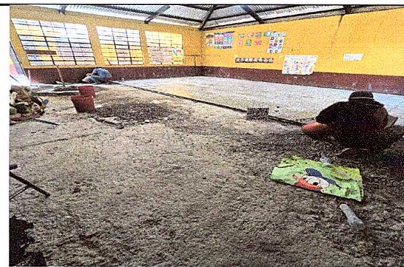
Foto 4: Renglón 2, sustitución de piso de granito (aulas)
