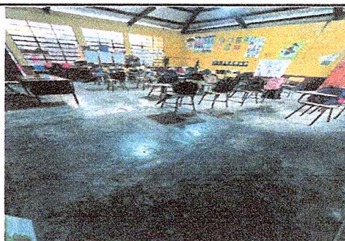
Foto 4: Renglón 2, sustitución de piso de granito (aulas)
