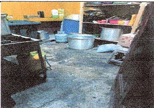
Foto 3: Renglón 2, sustitución de piso de granito (cocina escolar)
