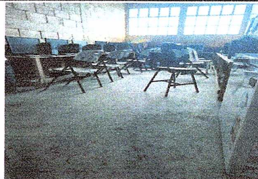
Foto 2: Renglón 2, sustitución de piso de granito (dirección)
