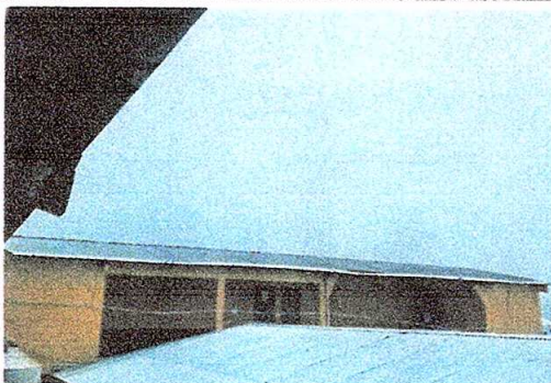
Foto1: Renglón 1, cubierta de lámina (segundo nivel)
