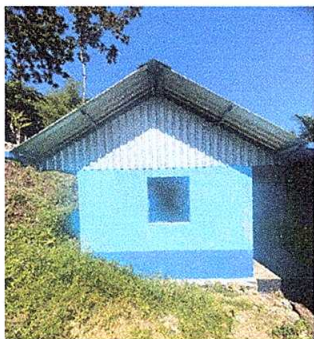
Foto 7: Pintura en paredes de cocina.
