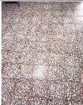
Foto 1: Sustitución de piso de torta de concreto por piso de granito
