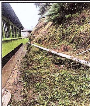
Foto 9: Sustitución de tubería PVC lineal principal de aguas negras. Y tubería lineal principal de agua potable.
