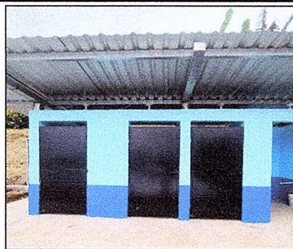
Foto 8: Mejoramiento de Servicios sanitarios y sus accesorios.
