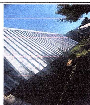
Foto 6: sustitucion de canales de PVC por canales de metal.
