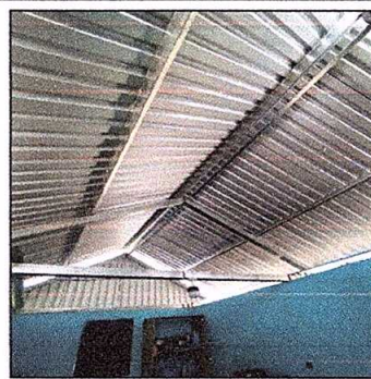
Foto 2: Sustrucción de estructura de soporte de madera, por metal.
