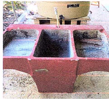
Foto 14. Sustrucción de pila de cemento de dos lavaderos
