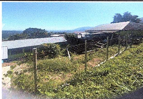
Foto 10: Sustitución de tubos y malla galvanizada.
