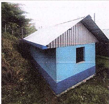
Foto 1: Sustrucción de lámina, por lámina troquelada.
