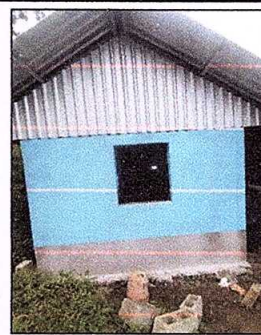
Foto 4: Sustitución de ventanas de madera por metal.
