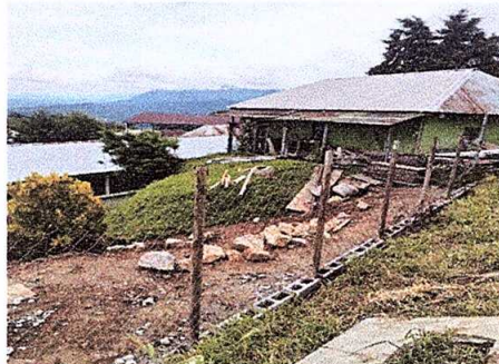
Foto 10: Sustitución de tubos y malla galvanizada.
