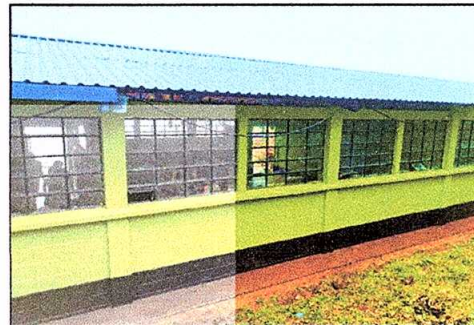
Foto 2: Sustitución de pintura en muros exteriores e interiores
