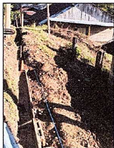
Foto 9: Sustitución de tubería PVC lineal principal de aguas negras. Y tubería lineal principal de agua potable.
