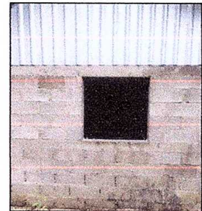
Foto 4: Sustitución de ventanas de madera por metal.
