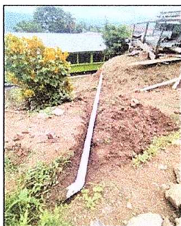
Foto 9: Sustitución de tubería PVC lineal principal de aguas negras. Y tubería lineal principal de agua potable.
