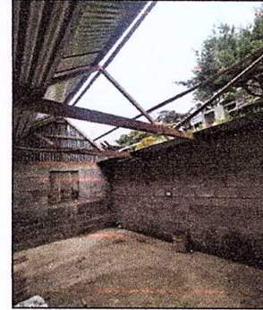
Foto 2: Sustitución de estructura de soporte de madera, por metal.
