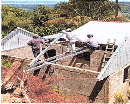
Foto 1: Sustitución de lámina, por lámina troquelada.
