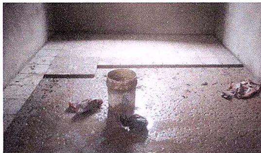
Foto 1: Sustitución de piso de torta de concreto por piso de granito
