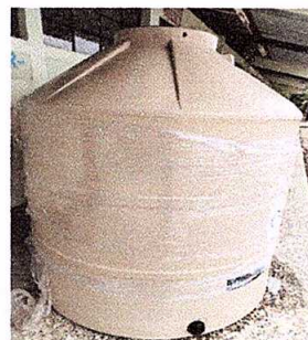
Foto 12. Sustitución de depósito de agua de 2500 Lts
