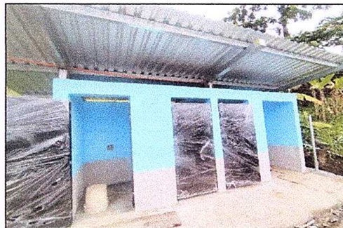
Foto 8: Mejoramiento de Servicios sanitarios y sus accesorios.
