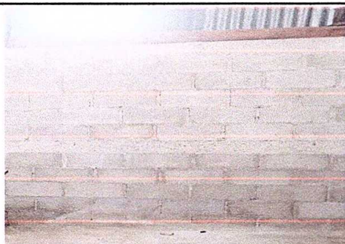
Foto 15. Repello en paredes de cocina
