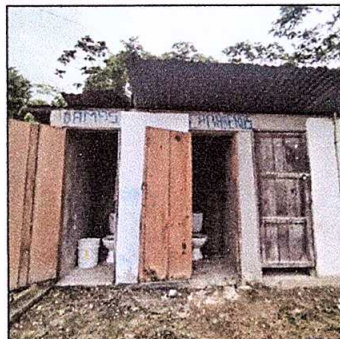
Foto 8: Mejoramiento de Servicios sanitarios y sus accesorios.
