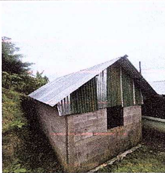
Foto 1: Sustitución de lámina, por lámina troquelada.
