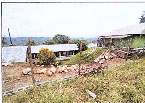
Foto 10: Sustitución de tubos y malla galvanizada.
