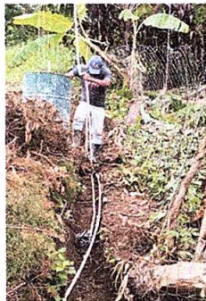
Foto 9: Sustitución de tubería PVC lineal principal de aguas negras. Y tubería lineal principal de agua potable.
