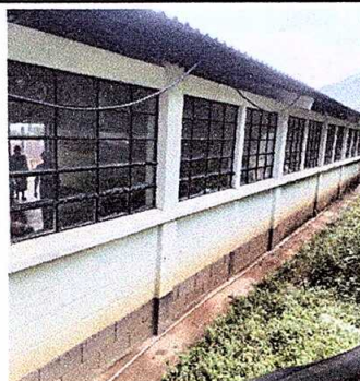
Foto 2: Sustrucción de pintura en muros exteriores e interiores
