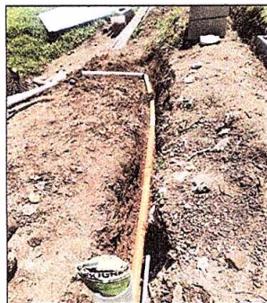
Foto 9: Sustitución de tubería PVC lineal principal de aguas negras. Y tubería lineal principal de agua potable.
