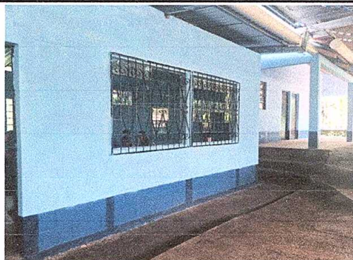
Foto 1: Pintura en muros exteriores e interiores
