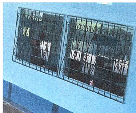
Foto 4: Sustitución de balcones de metal (1.70m de alto * 1.30m de ancho)
