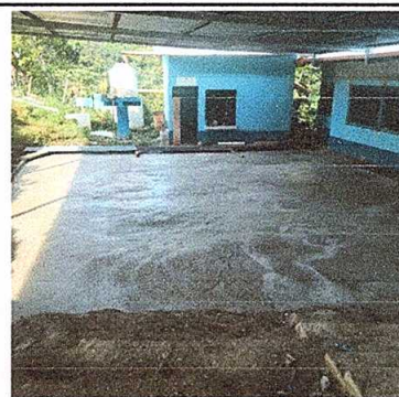
Foto 6: Sustitución de piso de torta de concreto
