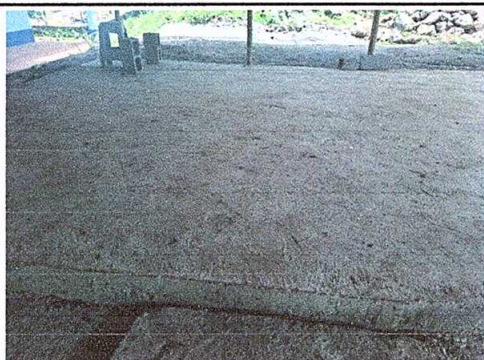
Foto 5: Sustitución de piso de torta de concreto
