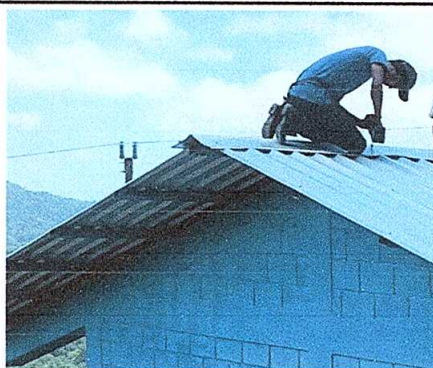
Foto 2: Sustitución de lámina, por lámina troquelada aluzinc calibre 26
