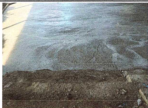
Foto 5: Sustitución de piso de torta de concreto
