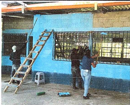
Foto 1: Pintura en muros exteriores e interiores
