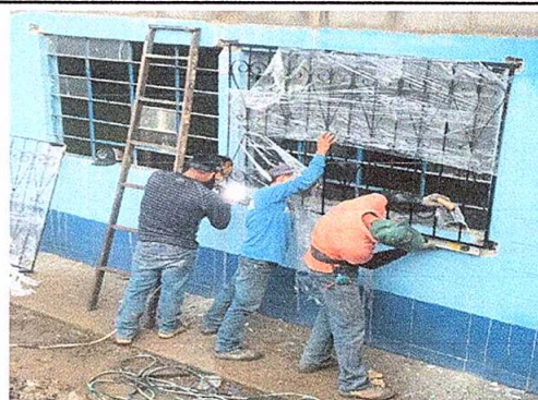
Foto 4: Sustitución de balcones de metal (1.70m de alto * 1.30m de ancho)
