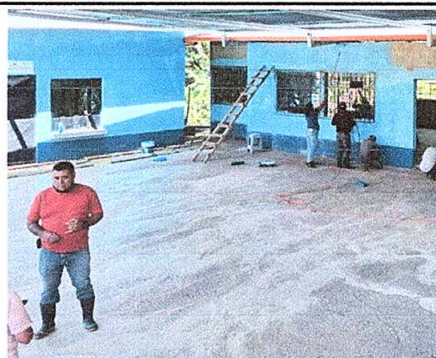
Foto 6: Sustitución de piso de torta de concreto
