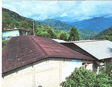
Sustitución de lámina, por lámina troquelada aluzinc calibre 26
