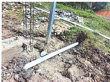
Foto 8: SUSTITUCIÓN DE TUBERÍA PVC
