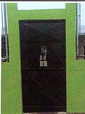
Foto 3: SUSTITUCION DE PUERTA
