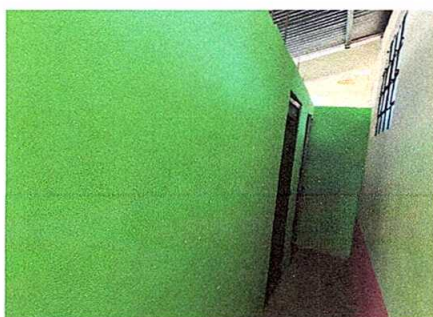
Foto 11: REPELLO EN PARED DE BAÑOS
