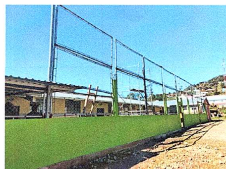
Foto 8: REPARACIÓN DE MURO PERIMETRAL
