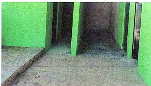
Foto 5: SUSTITUCIÓN DE PISO DE TORTA DE CONCRETO
