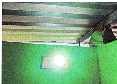
Foto 9: REPARACIÓN DE SISTEMA ELÉCTRICO
