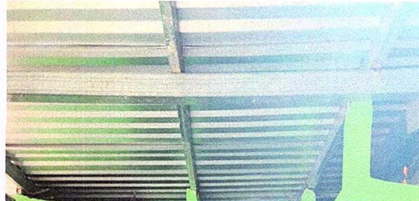
Foto 2: ESTRUCTURA DE TECHO
