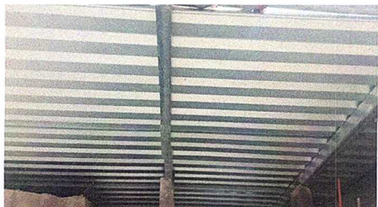
Foto 1: CUBIERTA DE LÁMINA
