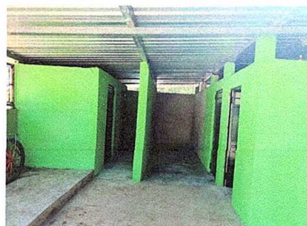
Foto 4: SUSTITUCION DE PUERTAS EN SERVICIOS SANITARIOS
