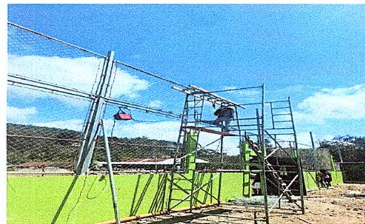
Foto 8: REPARACIÓN DE MURO PERIMETRAL
