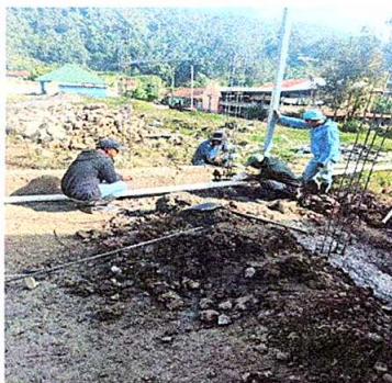
Foto 7: SUSTITUCIÓN DE TUBERÍA PVC
