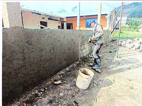
Foto 10: REPELLO EN PARED DE MURO PERIMETRAL
