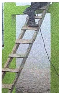
Foto 3: SUSTITUCION DE PUERTA
