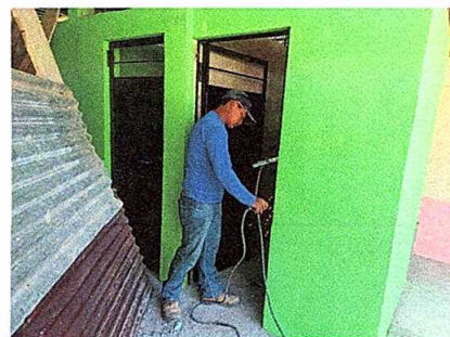
Foto 4: SUSTITUCION DE PUERTAS EN SERVICIOS SANITARIOS
