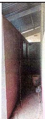
Foto 9: REPARACIÓN DE SISTEMA ELÉCTRICO
