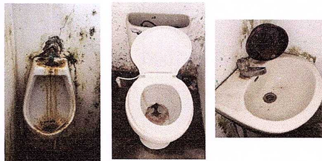
Foto 6: SUSTITUCIÓN DE INODOROS, LAVAMANOS Y MINGITORIOS
