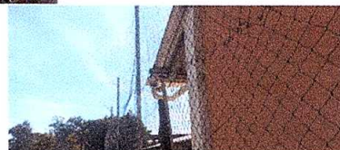
Foto 8: REPARACIÓN DE MURO PERIMETRAL
