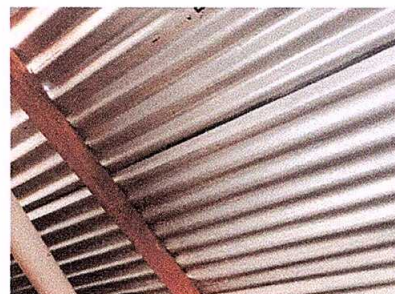
Foto 2: ESTRUCTURA DE TECHO
