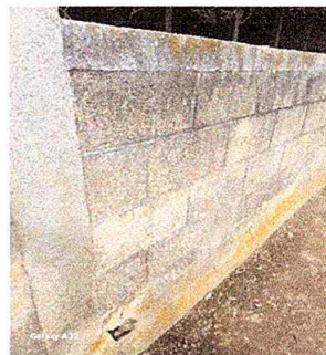
Foto 10: REPELLO EN PARED DE MURO PERIMETRAL
