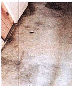
Foto 5: SUSTITUCIÓN DE PISO DE TORTA DE CONCRETO
