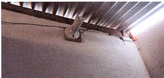
Foto 9: REPARACIÓN DE SISTEMA ELÉCTRICO
