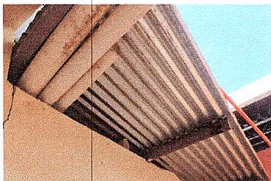
Foto 1: CUBIERTA DE LÁMINA
